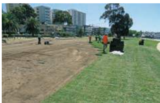
Instalación de Village Green® en rollos standard
