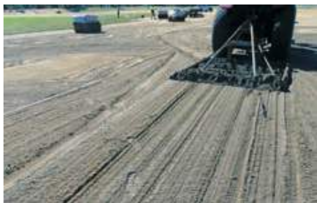
Nivelación de la superficie
