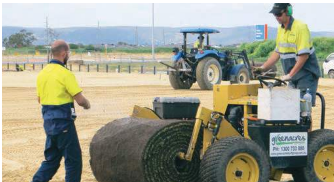
Instalación de Village Green® en rollos grandes
